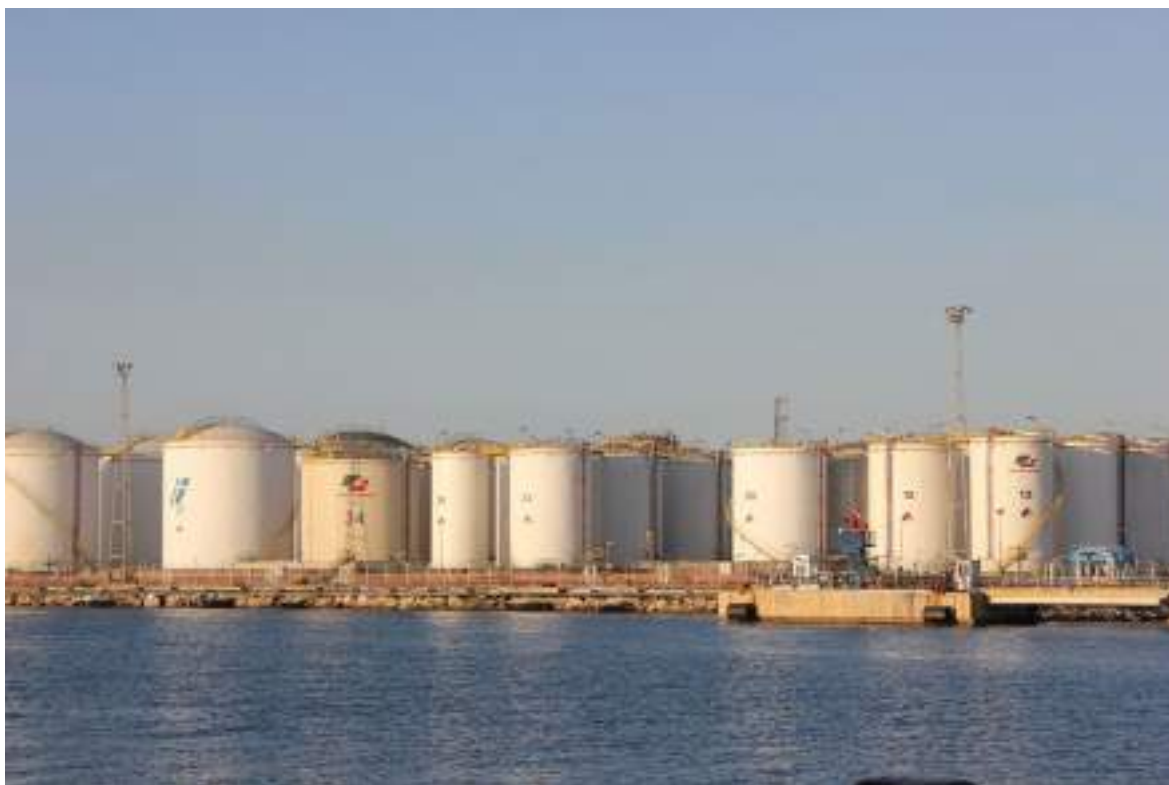
Foto tanques cilíndricos verticales de Terquimsa-2 (Tarragona)
