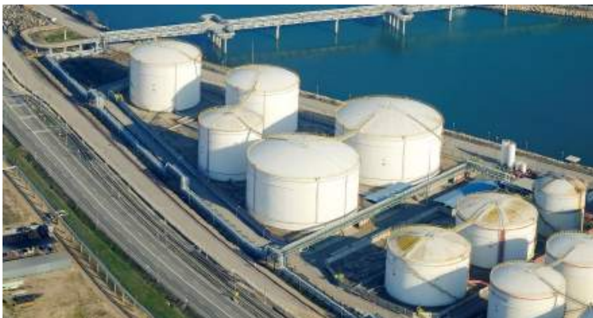
Foto: Vista aérea Terquimsa-3 (Tarragona)
